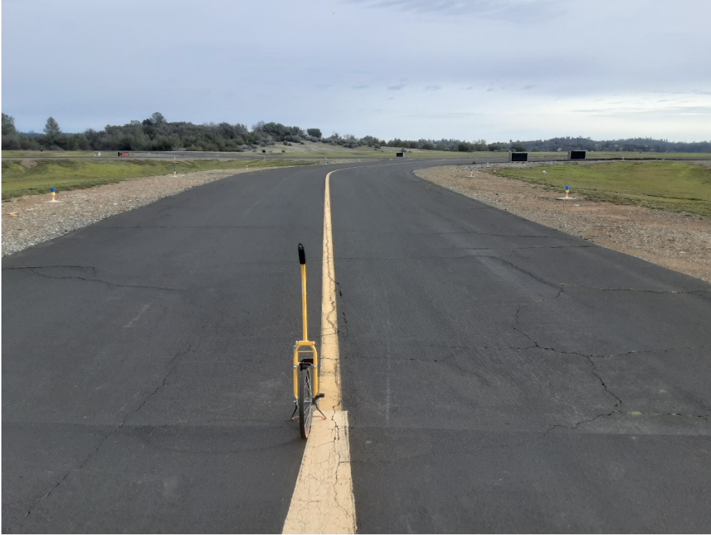
T5 A. LT cracking (Sample Unit No. 02).
