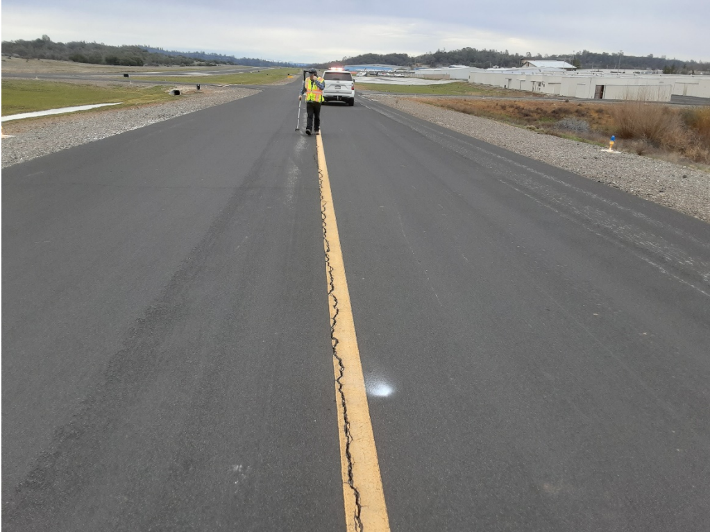
T1 A. LT cracking (Sample Unit No. 04).
