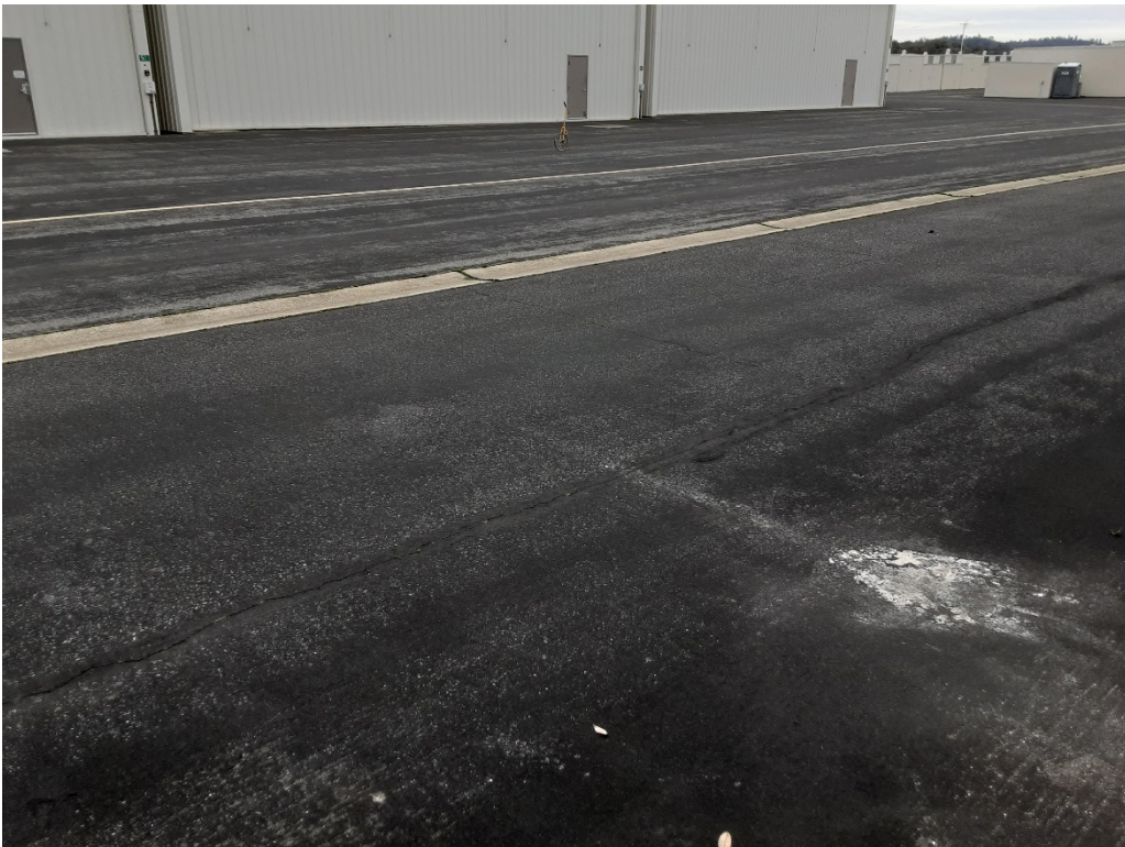
TD5 A. LT cracking (Sample Unit No. 05).
