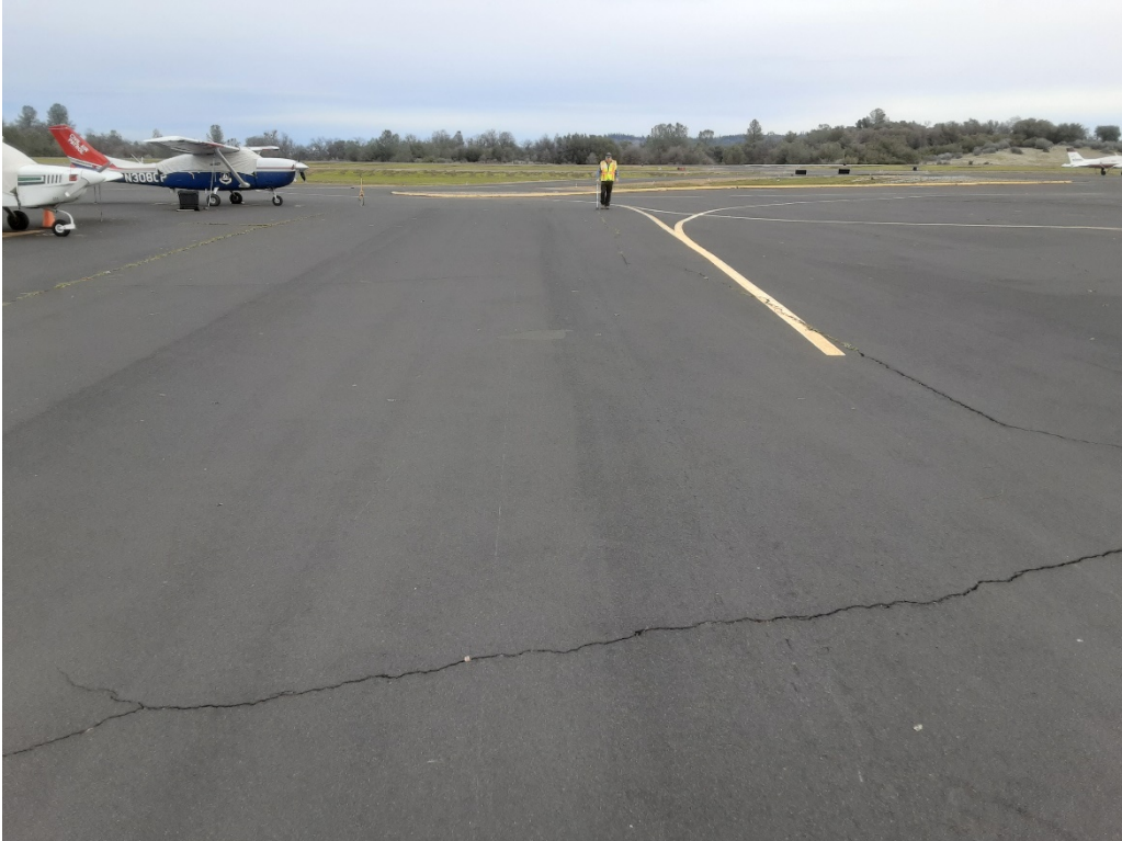
A2 A. LT cracking (Sample Unit No. 02).
