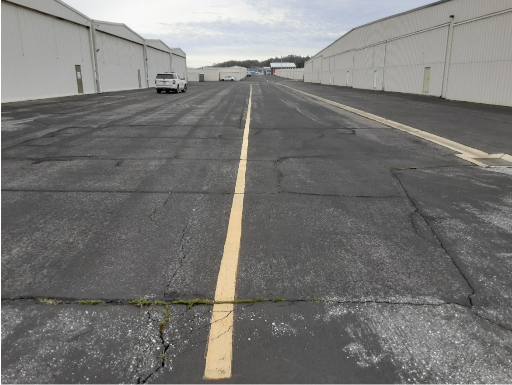
TD5 A. LT cracking (Sample Unit No. 02).
