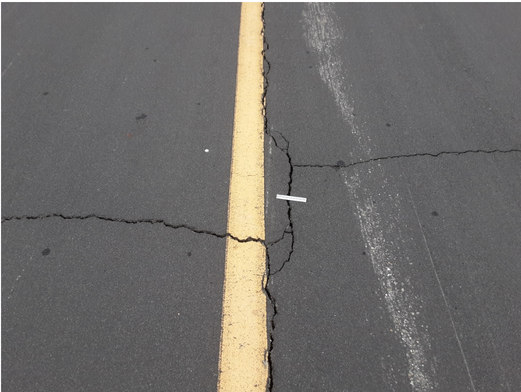
T1 A. LT cracking (Sample Unit No. 04).
