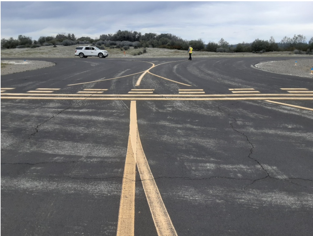
T4 A. LT cracking (Sample Unit No. 01).
